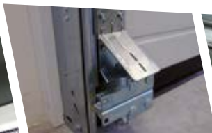
Paracadute cavi Cable break safety device Seilbruchsicherungsvorrichtung
